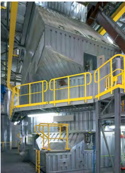
Rauchgas Luftvorwärmer
